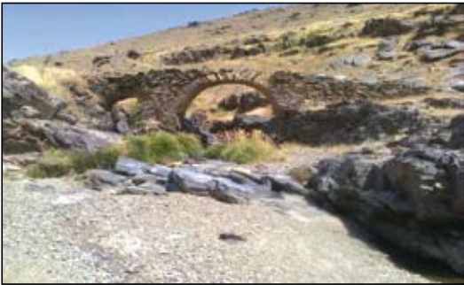
پل سلطان با طول ۲۰ متر و عرض ۳.۵ متر، از دو طاق رومی تشکیل شده که طاق کوچک تر با عرض سه متر و ارتفاع یک متر و ۳۰ سانتی متر
